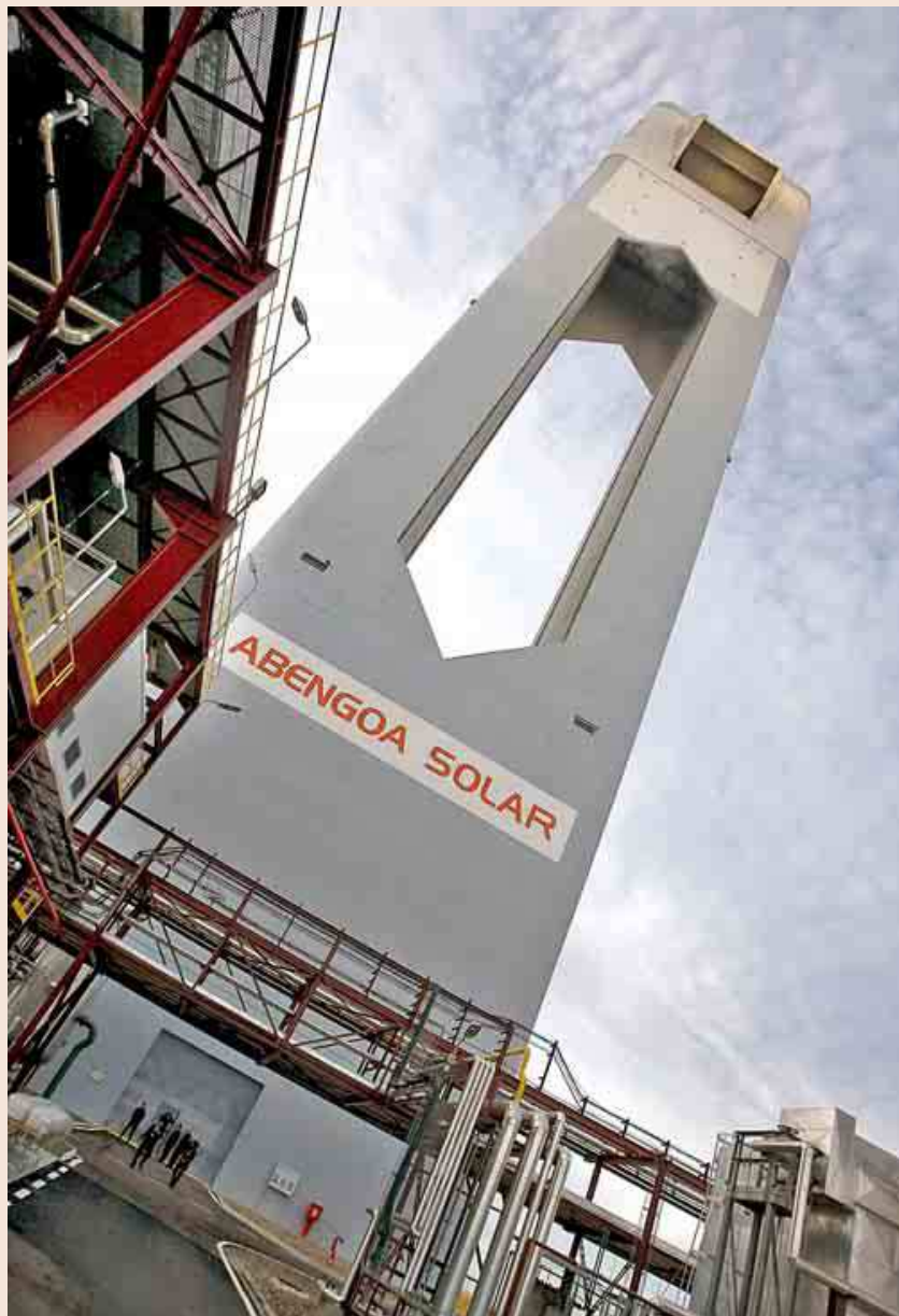
Vista de la planta de energía termosolar que Abengoa posee en Sanlúcar La Mayor (Sevilla). / EFE
